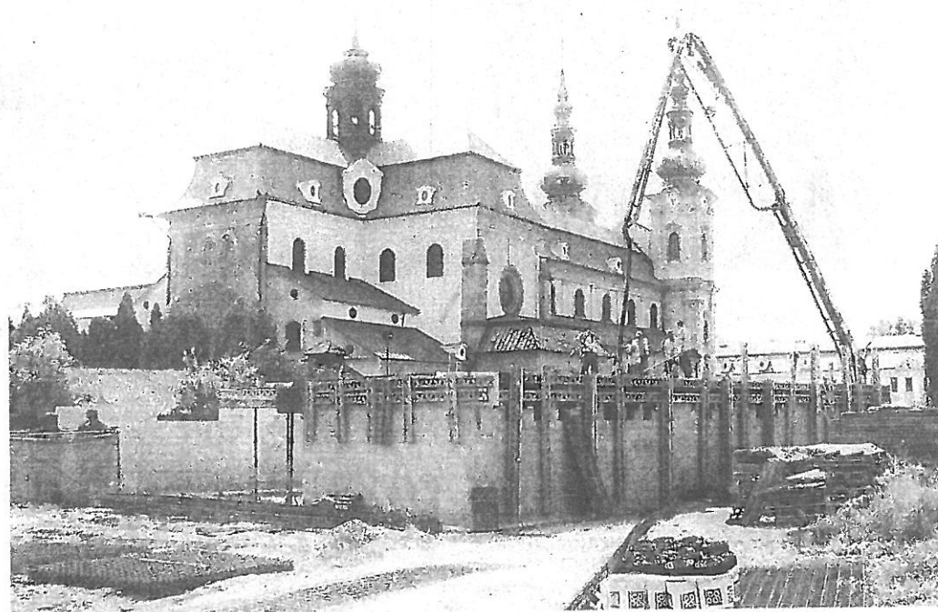
STAVENÍŠTĚ. Mezi kaplí Cyrilka a bazilikou vyrůstají WC v hodnotě sedmi milionů korun. Foto: Zdeněk Skalička
